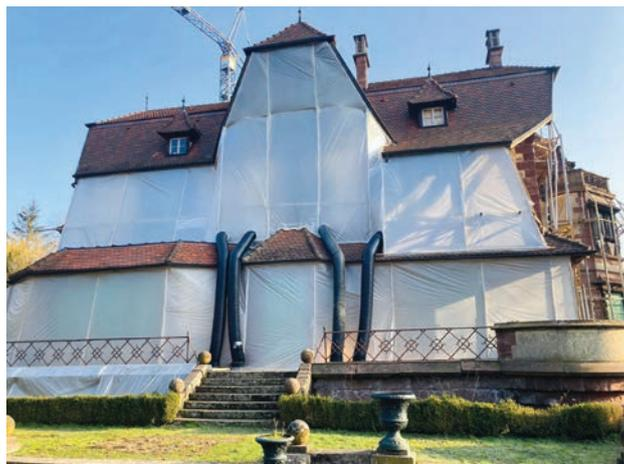
Les façades du château ont été entièrement bâchées au sein d'une enveloppe étanche. La température de l'air a été portée à près de 80°C par d'impressionnants générateurs thermiques, de telle sorte à provoquer un choc de température de 50°C, à l'intérieur des murs, éradiquant ainsi totalement le champignon destructeur.
