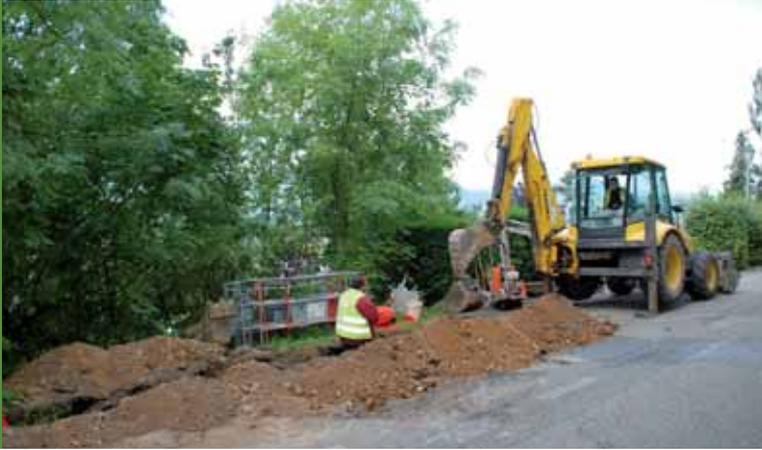
Dans le cadre de la programmation pluriannuelle de remplacement des candélabres et réseaux d'éclairage public, l'éclairage de la rue de la Moyenne Corniche est en cours de restructuration. En effet, les appareillages et le câblage n'étaient plus aux normes et provoquaient de nombreuses coupures de courant.
